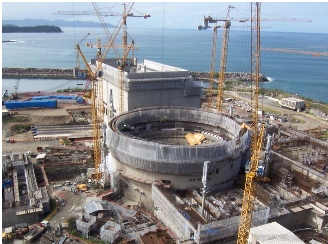
Figura 48 – Construção da Usina de Angra 3
